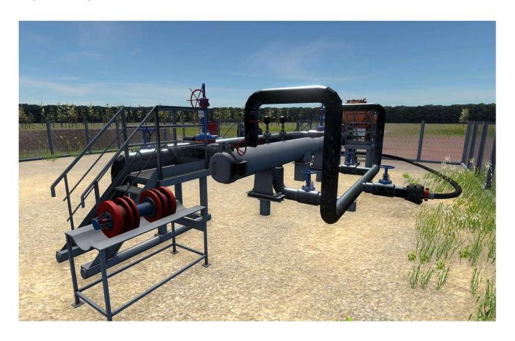
Компьютерный тренажер «Камера запуска и приёма средств очистки и диагностики» (КПП СОД) разработан для формирования и улучшения знаний, умений и навыков операторов в области обслуживания кустовых площадок.
